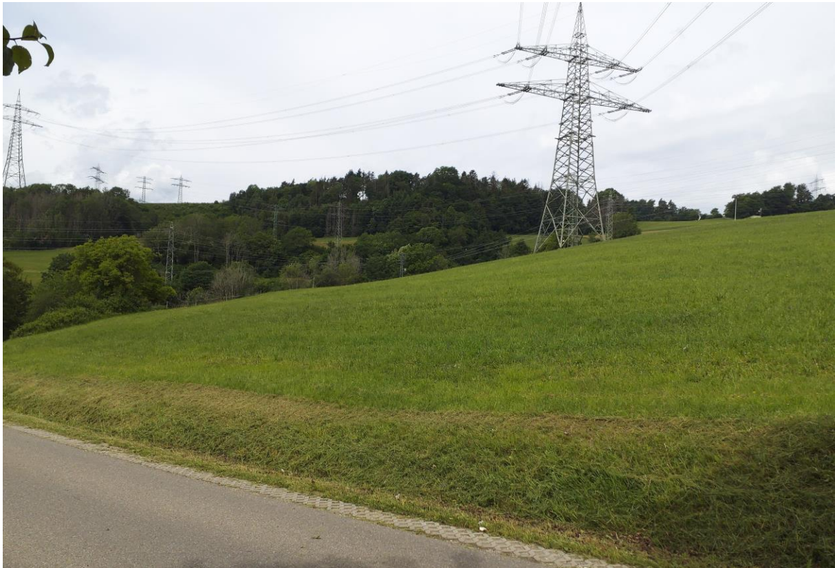
Abb. 3: Blick von der „Kapellenstraße“ nach Westen auf das Plangebiet. Foto bhm.
